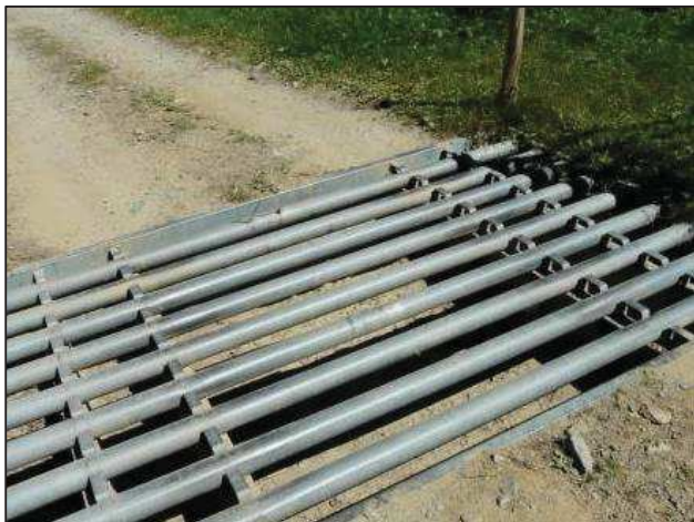
Illustration 185 : Photo d'un passage canadien
