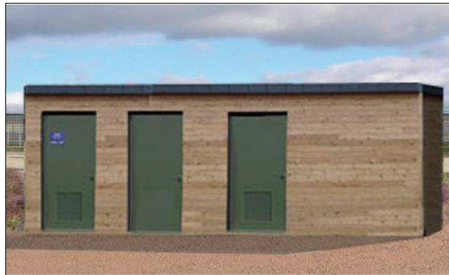
Illustration 191 : Exemple de poste de livraison avec bardage bois horizontal et traitement des menuiseries
