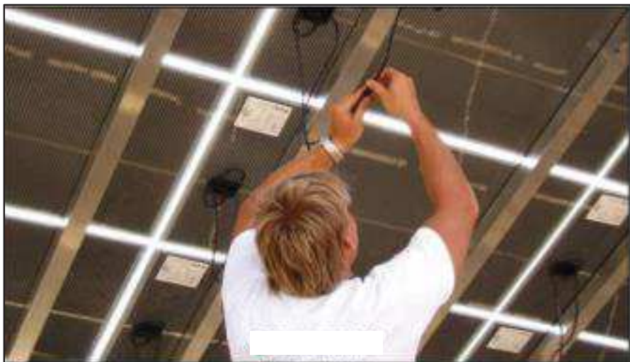
Illustration 166 : Vues des interstices de 2 cm entre chaque panneau
